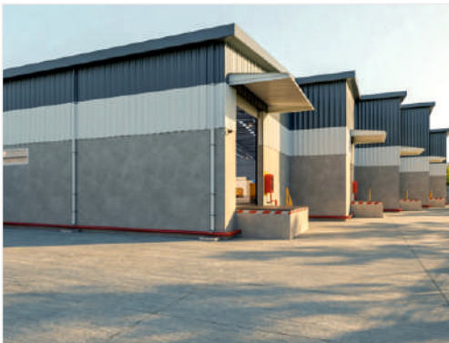
KATSAON LOGISPACE - RAJKOT
